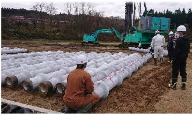
地盤の上に安定して建築できるようにするための基礎杭打工事も開始。
