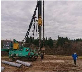
地盤の上に安定して建築できるようにするための基礎杭打工事も開始。
