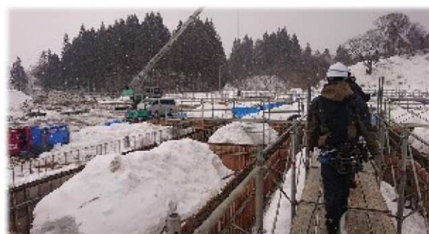
鉄筋の配筋状態・かぶり厚などの調査を実施。
