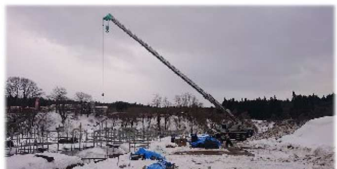
冬期も休むことなく工事は継続中です。
